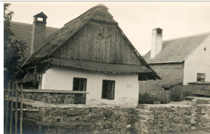
Dům čp. 60 před demolicí. (V popředí základy stávajícího domu čp. 60, vpravo v r. 1975 zbouraný dům čp. 57; foto z r. 1947.)
