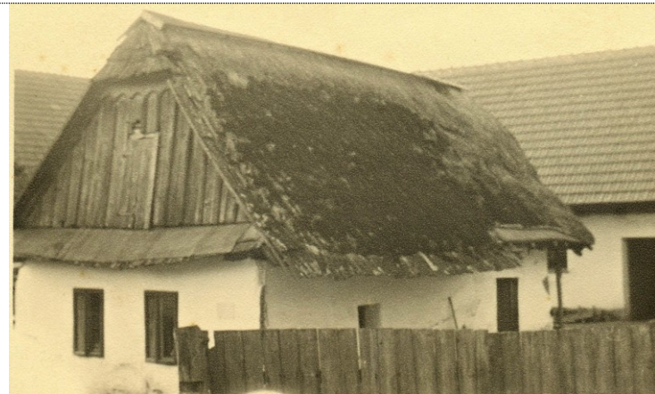
Dům čp. 60 před demolicí. (R. 1947.)
